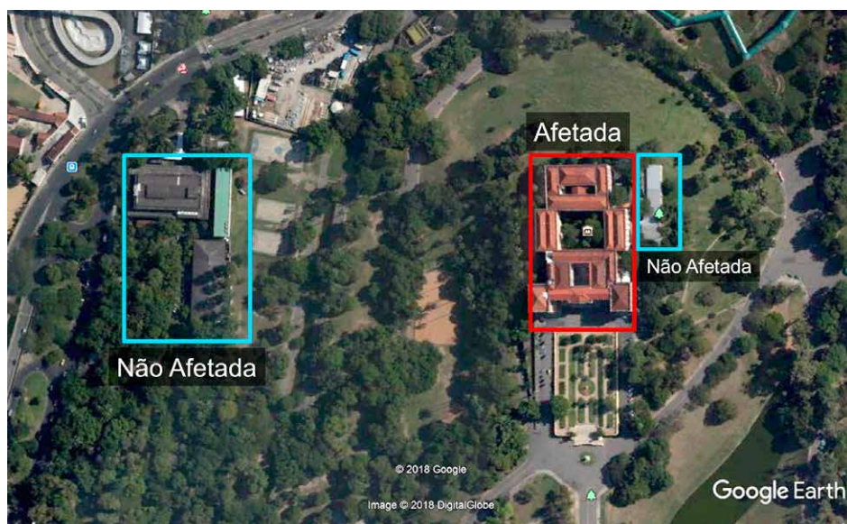
Figura 1. Edifícios afetados (em vermelho) e não afetados (em azul) durante o incêndio no Museu Nacional/UFRJ, no dia 2 de setembro de 2018. Imagem adaptada do Google Earth.
